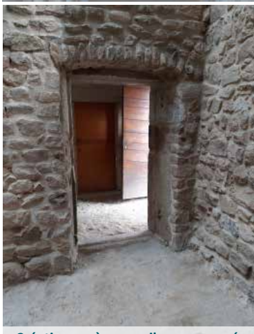
Création accès accueil, vue opposée
