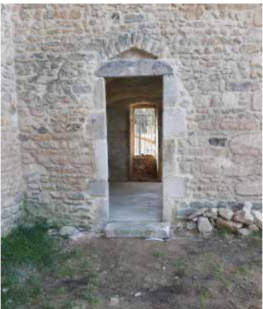
Ouverture accès sanitaire : transformation d'une fenêtre en porte
