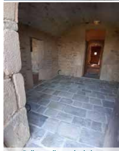
Dallage salle carrée du bas
