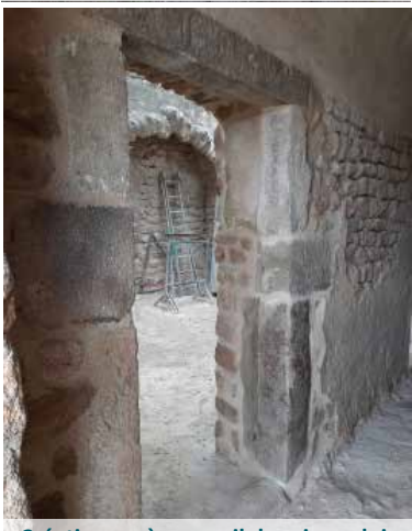
Création accès accueil depuis couloir
