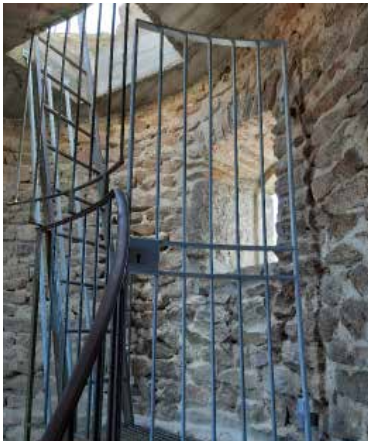
Sécurisation d'une tour
