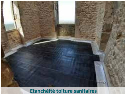
Etanchéité toiture sanitaires
