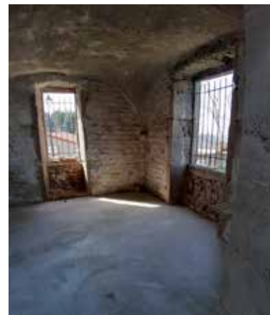
Préparation dallage sanitaire
