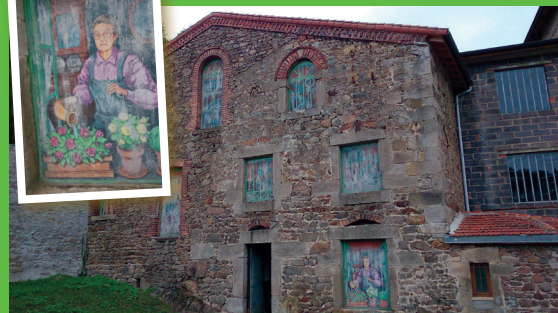
Façade du vieux moulin
